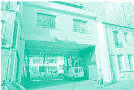
Porche de l'usine d'emboutissage Moulinex à Bagnolet. Photo : Farouk Derdour, Archives départementales de la Seine-Saint-Denis.
