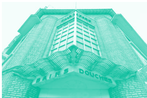
Façade des bains-douches de la rue Petitot dans le XIX e arrondissement de Paris. Photo : Laurent Kruszyk, Région Île-de-France.
