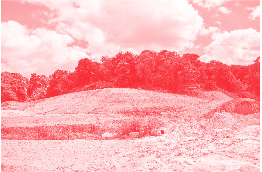
La forêt en chantier (juin 2019). Photo : de Vincent Ducard.
