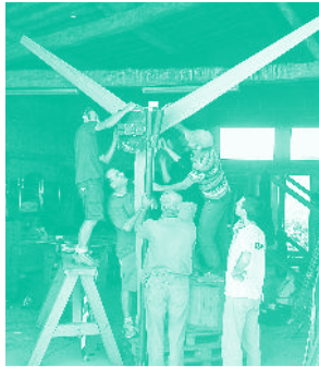
Construction de l'éolienne de Hugh Piggott. Avec son aimable autorisation.
